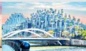
อาคารฟันทันไม้
